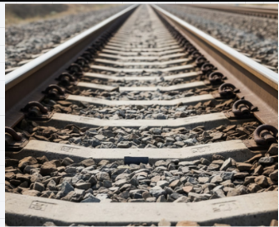
Tren raylarının arası açılması
