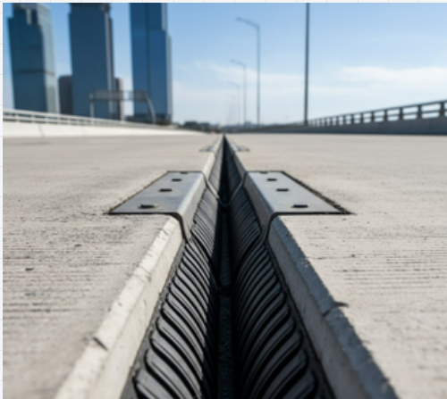
Beton yapılar arasında boşluk bırakmak
