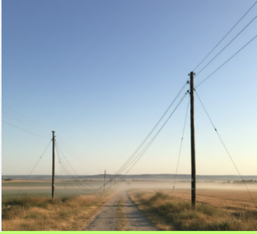
Yazın elektrik tellerin sarkması
