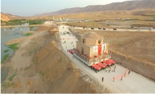
Şekil 1: Artuklu Hamamı'nın taşınmasına ait fotoğraf
